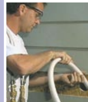
Existing Stud Walls
